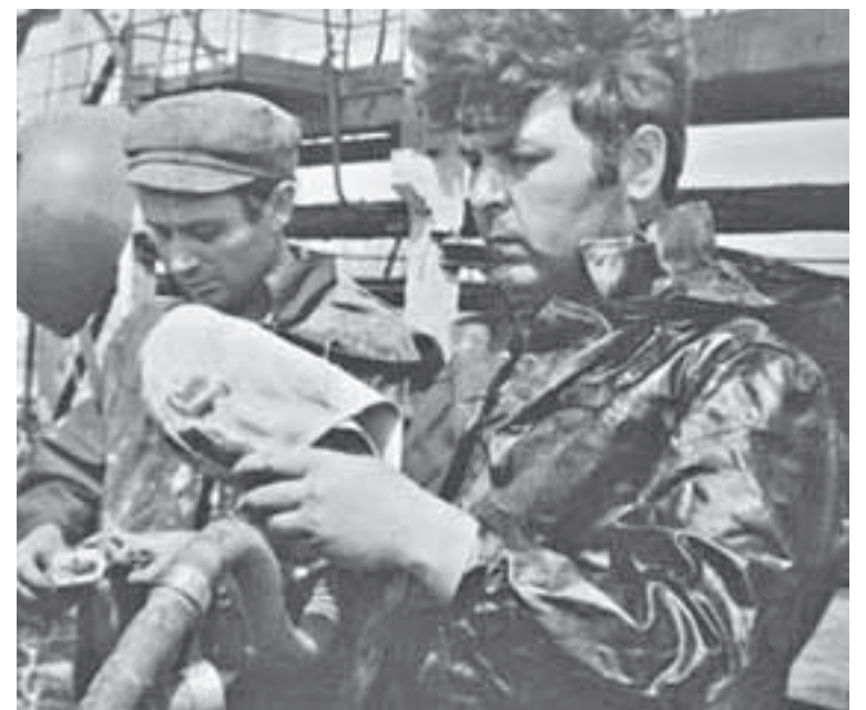
Иосиф Душанек на строительстве ПК «Шесхарис».
